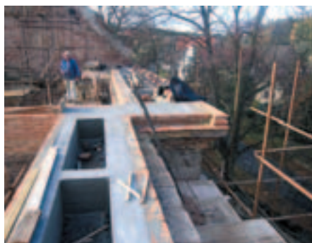
Obnažené zdivo kostelíka muselo být nejdříve zpevněno železobetonovým věncem (stav prací v 11/06)
